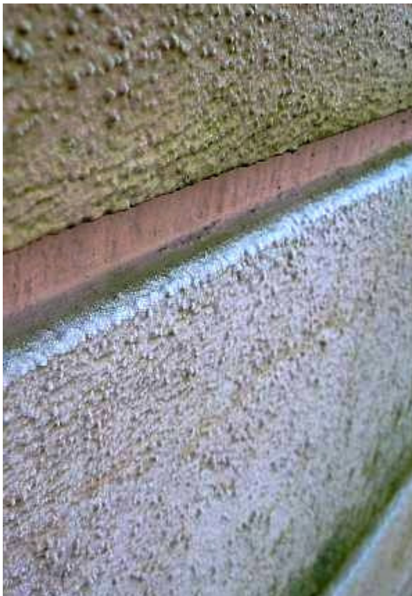
Abbildung: Vereiste und veralgte WDVS-Beschichtung am 23.12.06
