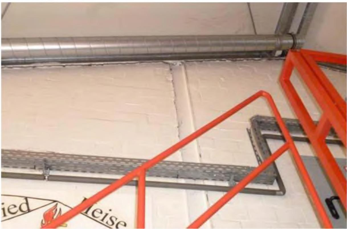
Hallenkonstruktion: Stahlskelettbau ausgemauert.
