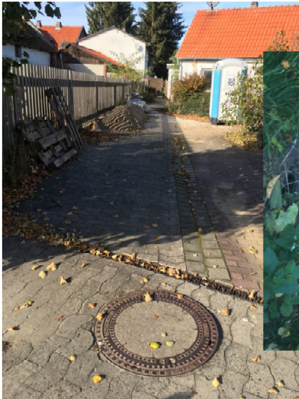
Abbildung 3: Verlauf des verrohrten Grabens mit Blickrichtung nach Norden (von Magdeburger Str.).
